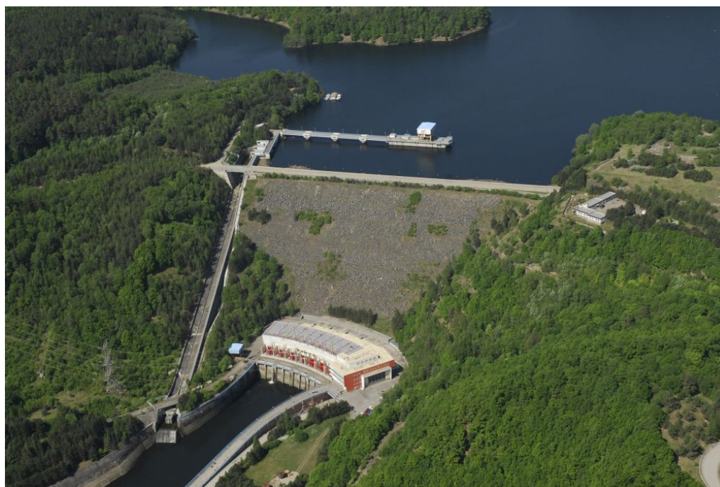
Obrázek 2.4: Pohled na PVE Dalešice
